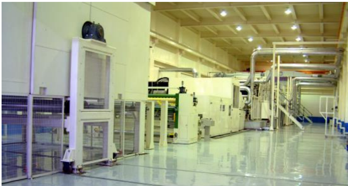
水針不織布設備 德國DILO/法國RIETER製 高速機 200m/分
